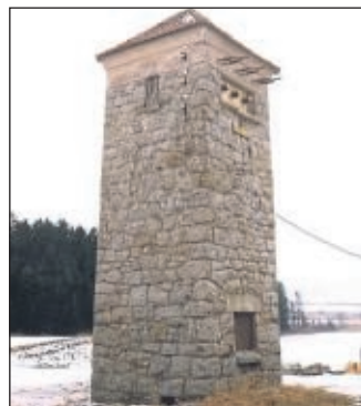
Trafoturm aus Naturstein im Raum Havixbeck-Nottuln. Wer kennt den (einstigen) Standort? Foto: privat
