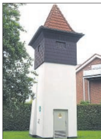
Dieser Turm in Nottuln-Darup zeigte in den 1920er-Jahren noch gemauertes Fachwerk im oberen Bereich; jetzt ist das Fachwerk verdeckt.
