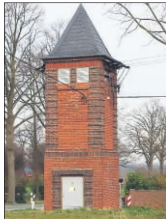
Ein Blickfänger ist auch dieses Traföhäuschen in Seppenrade-Orndrup an der B 474.
