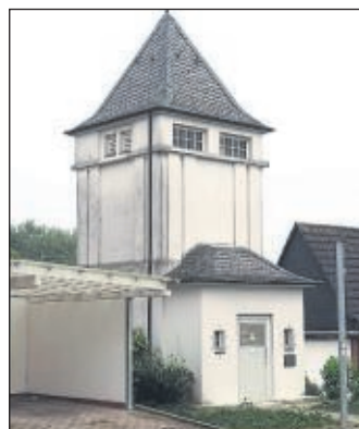
Inmitten von Wohnbebauung steht dieser Trafoturm in Nottuln. Fotos: Ludger Schröer
